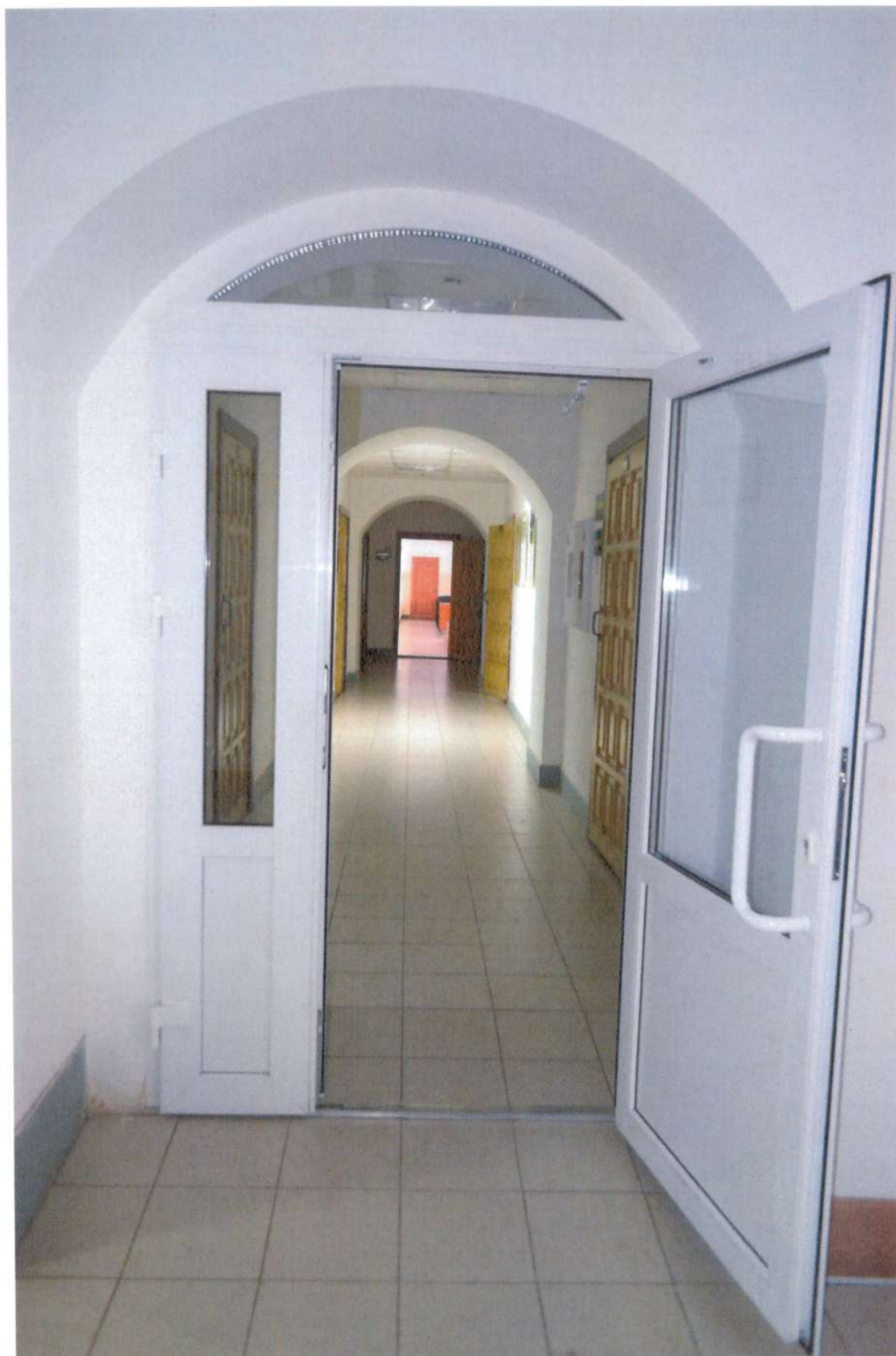
Путь (пути) движения внутри здания (в т.ч. пути эвакуации) Фото 10.1.
