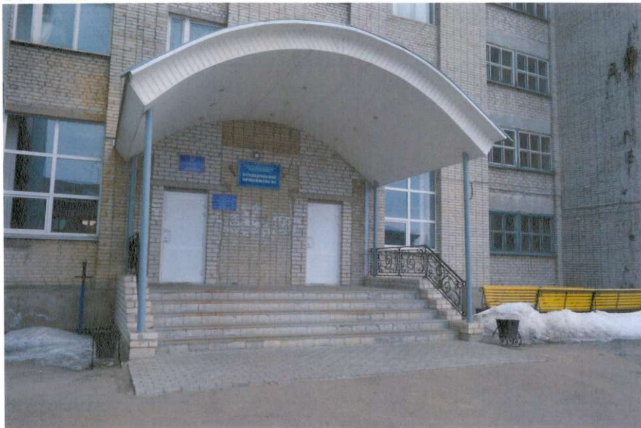
Вход (входы в здание) Фото 16.1.
